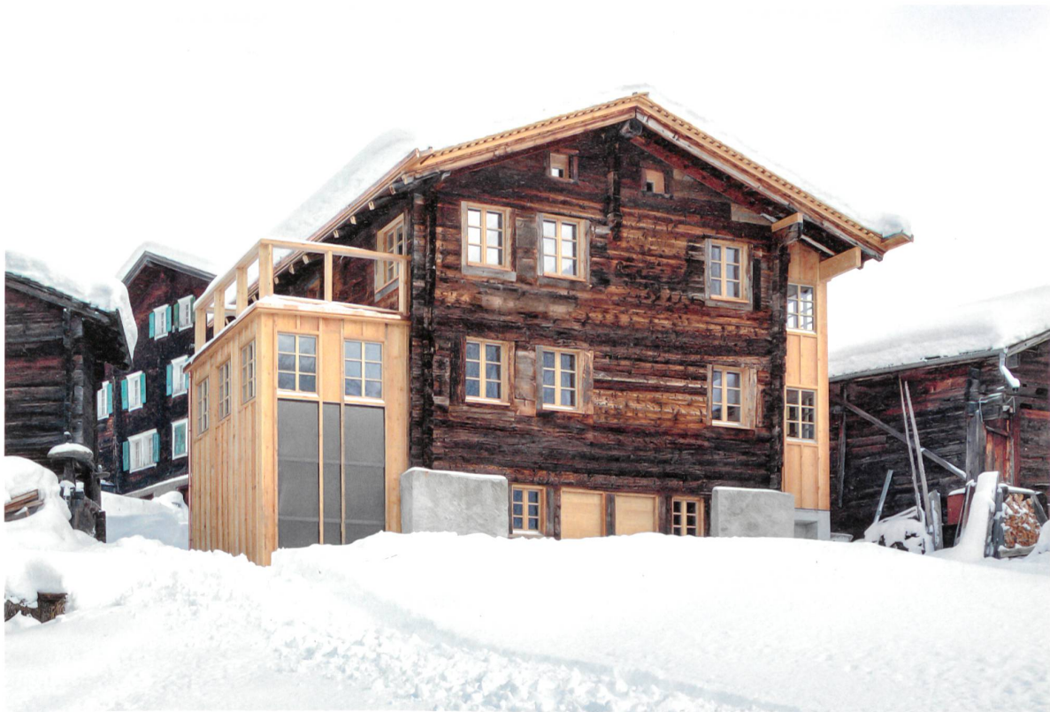
Bei den Anbauten dominierten das wetterbeständige Lärchenholz und die eingebauten Sonnenkollektoren . Sägerohre Bretter sind in ihrer maximalen Breite stumpf gestossen und deren Fugen mit einer Deckenleiste geschlossen.
