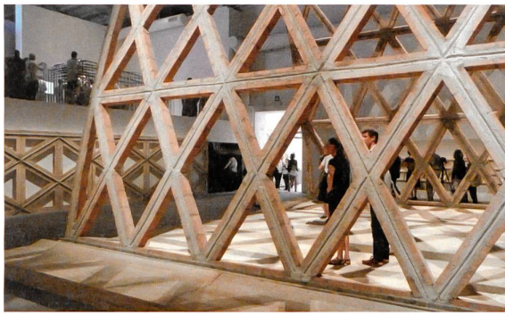
Die Gruppe Gabinete de Arquitectura baut in Paraguay mit ungelernten Arbeitern Gewölbeskelette aus Backstein .
