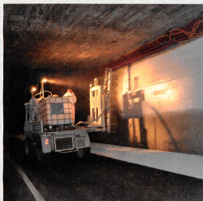
Automatisierte Beschichtungsarbeiten in der Schallbettgalerie durch die Fa. Trauffer AG, Brien
