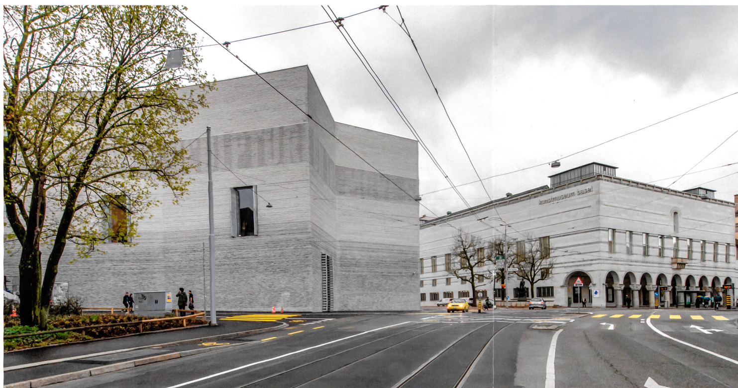
Die Loslösung in städtebaulicher Ausprägung und innenräumlicher Aufteilung erreicht die Erweiterung über die verwandte, nicht die komplementäre Haltung zum Hauptbau. Dank der eingehenden Beschäftigung mit dem Hauptbau erscheint auch dieser – zur Entstehungszeit heftig kritisiert – in neuem Licht.
