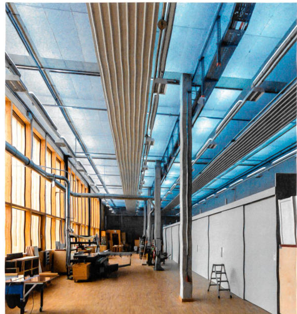
Links: Die direkte Komponente erfüllt die Norm. Rechts: Die Indirektkomponente hat einen hohen Blaulichtanteil, der das Wachwerden anregt. Je nach Tageszeit und Tageslichtanteil wird entweder die direkte oder die direkte und indirekte Beleuchtung eingeschaltet.
