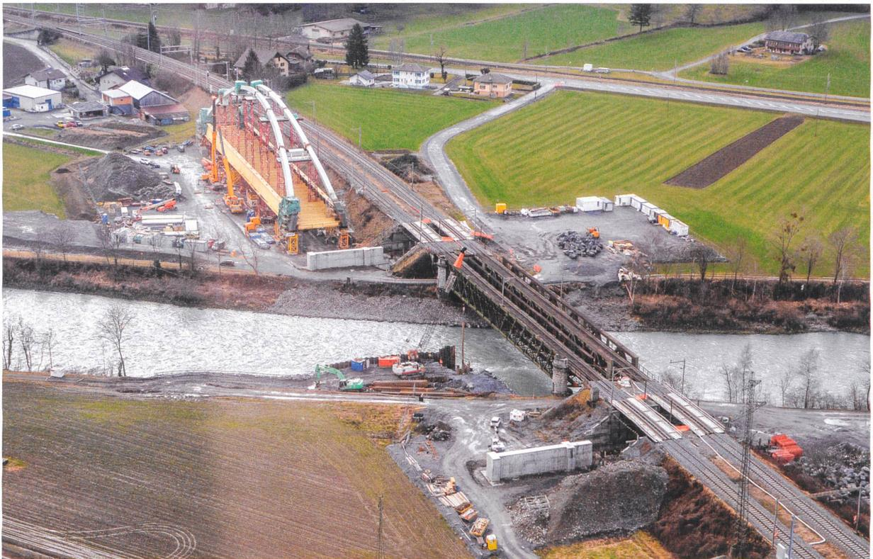
**Stahlkonstruktion der neuen Brücke auf dem Installationsplatz** mit den beiden Vorschublagerern beidseits der Rhone und der Plattform für die provisorischen Pfeiler am rechten Ufer. Die beiden definitiven Widerlager entstehen in den Baugruben im Eisenbahndamm unter den vier Behelfsbrücken (Fließrichtung von links nach rechts).
