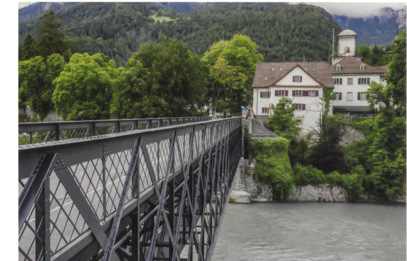
Baukultur meint auch den Erhalt historischer Ingenieurbauwerke – wie etwa der 135 Jahre alten Eisenfachwerkbrücke über den Rhein bei Reichenau GR . Sensibel erneuert wurde die Brücke 2014/15 vom Ingenieurbüro Konzett Bronzini Partner aus Chur.
