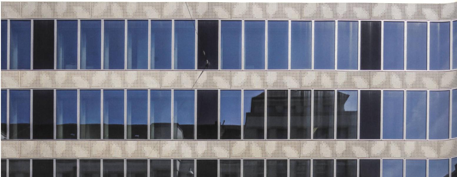
Betonbrüstung individuell: Für die Blätteroptik am Objekt Bleicherweg, Zürich, sorgen Rundungen, die verschieden gross und tief sind. Weitere Ideen und Umsetzungen: [betonelementwerk.ch](http://betonelementwerk.ch)
