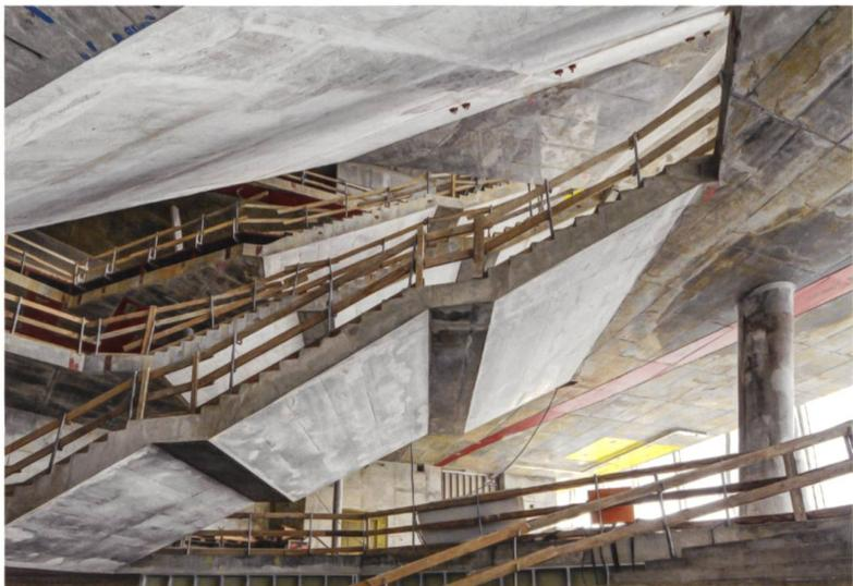
Die hochkomplexe **Tragkonstruktion aus Stahlbeton** bildet eine Landschaft aus Decken, Stützen und Treppen. Farbige Stellen markieren die Lage von Vorspannkabeln – statisch neutralgische Zonen, die keinesfalls verletzt werden durften.
