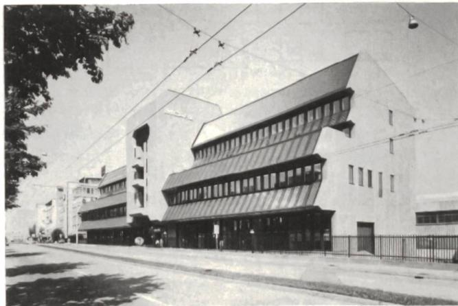
Grundrissanlage von Südosten. Auf dem westlichen Trakt am Dachgeschoß befinden sich Sonnenkollektoren, auf dem östlichen Teil besteht die Möglichkeit, für den späteren Einbau weiterentwickelter Kollektoren. In den Brüstungen der 1. und 2. Obergeschosse erkennt man die Luftkollektoren
