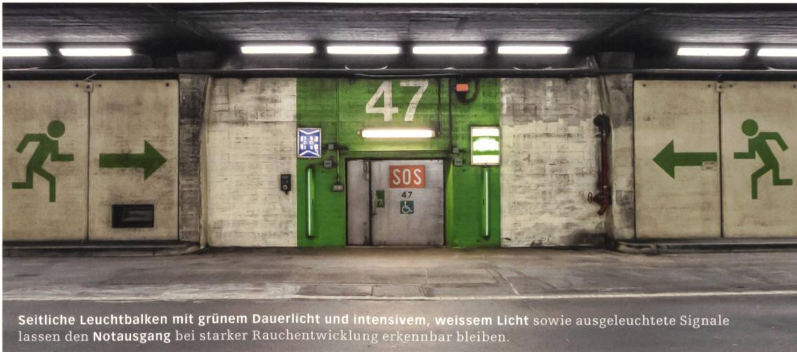
Seitliche Leuchtbalken mit grünem Dauerlicht und intensivem, weissem Licht sowie ausgeleuchtete Signale lassen den Notausgang bei starker Rauchentwicklung erkennbar bleiben.
