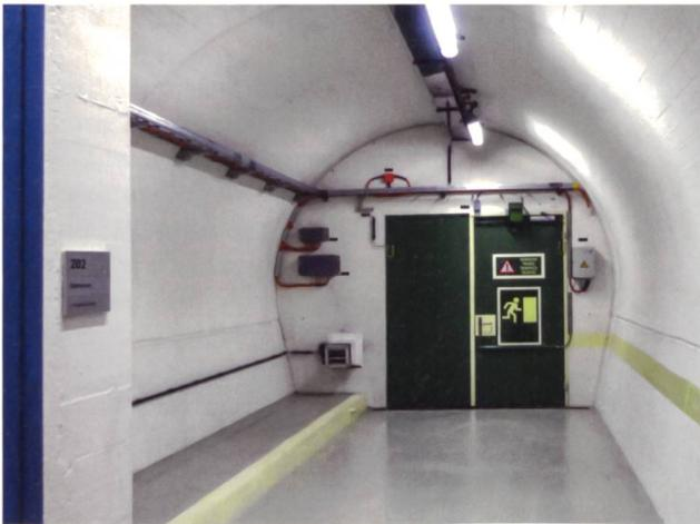
Bei einer Flucht aus dem Haupttunnel gelangt man zunächst in eine **Querverbindung**. Diese ist beleuchtet und mit Fluchtwegsignalisierung ausgerüstet. Von der Querverbindung gelangt man in den Fluchtstollen.
