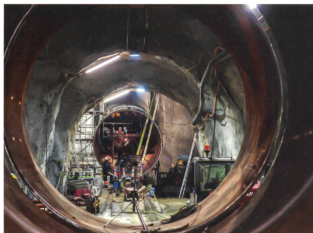
Einbau der Stahlpanzerung in die Oberwasserdruckschächte.
