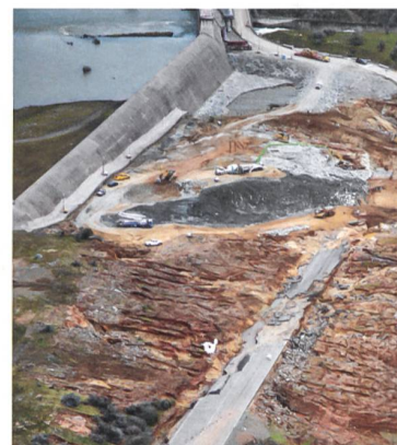
Luftansicht der erodierten Landschaft unterhalb des Dammüberlaufs.
