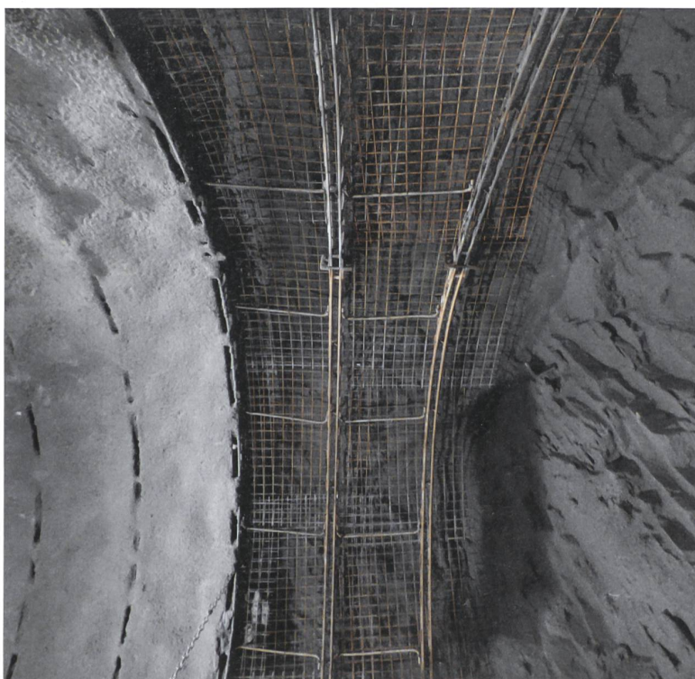
Die Firste an der Ortsbrust des neuen Albula-II-Tunnels auf Seite Preda.
