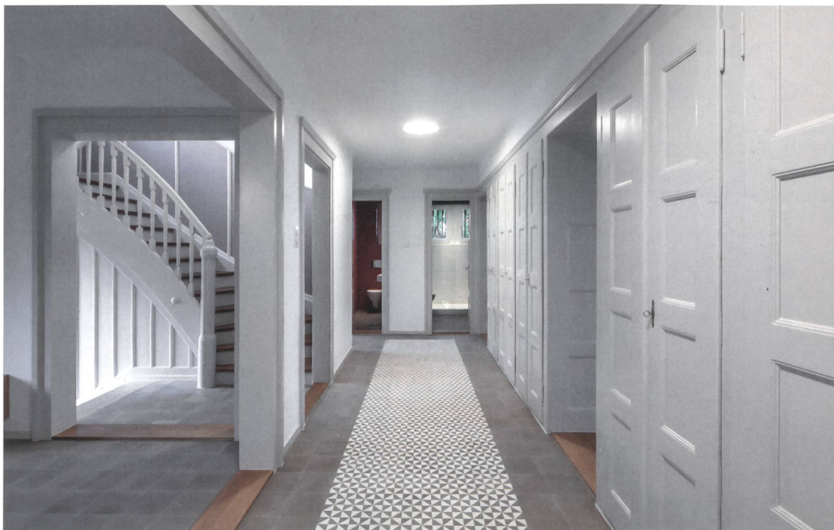
In der ehemaligen Küche befindet sich heute der neue Eingangsbereich. Wände zum Treppenhaus und zum Wohnungsflur wurden entfernt, die Bodenschwellen aber am Boden belassen, damit sich die Eingriffe deutlich abzeichnen. Das Entree ist mit grauen Zementplatten (mit einer darunter liegenden Bodenheizung) gestaltet und setzt sich im anschliessenden Korridor mit einer grafisch gemusterten Variante fort.
