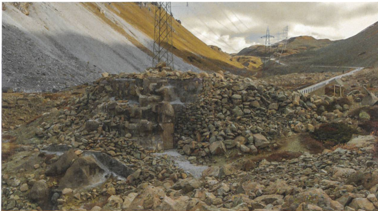
Zweifellos kein Kulturland – aber eine Landschaft mit starker Identität: Stromtrasse, Passstrasse und getarnter Bunker am Albulapass in Graubünden.
