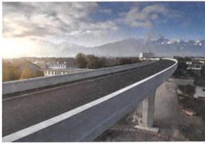
Mit dynamischem Schwung umfährt die neue Aarebrücke als Herzstück des Bypass Thun Nord die Altstadt. Coverfoto von Bänziger Partner .
