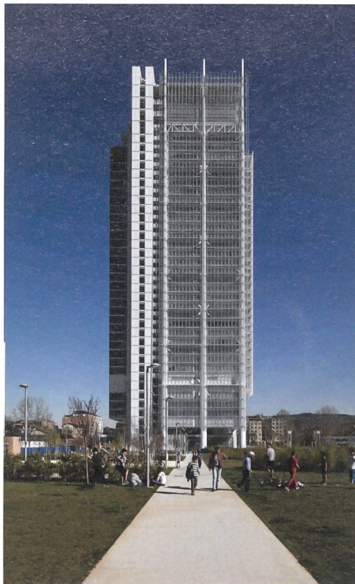
7 Il grattacielo, massiccio e allo stesso tempo leggero, si staglia come una macchina sopra lo skyline di Torino.
