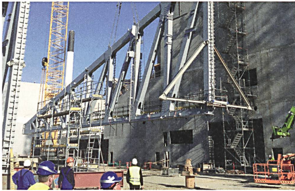
Einhub des ersten Dachbinders mit 90 t.
