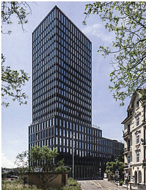
Schweizer Solarpreis 2017: Grosspeter Tower, Basel (vgl. TEC21 24–25/2017). Alle Fassaden des 21-stöckigen Hochhauses sind mit Photovoltaik bestückt, wobei die dunklen Elemente zu einer tectonisch anmutenden Hülle gefügt sind. Die 440-kW-Anlage und weitere Photovoltaikpaneele auf dem Dach produzieren total ca. 252 000 kWh/a. Daraus resultiert eine Eigenenergieversorgung von 28 %.
