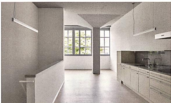
**Maisonettewohnung (oben) und Loftwohnung im Werkstattgebäude:** Die Pilzstützen des Altbaus prägen die Identität der Räume. Die alte Fassade wurde samt Betongitter erhalten, die bestehende Verglasung durch neue Fenster ersetzt.
