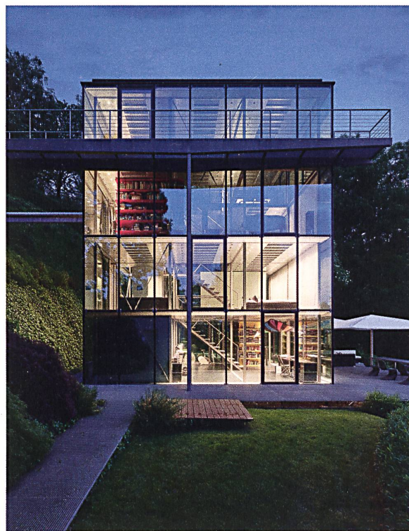
Wohnhaus R128: modularer Aufbau und gesteckte Konstruktionselemente.
