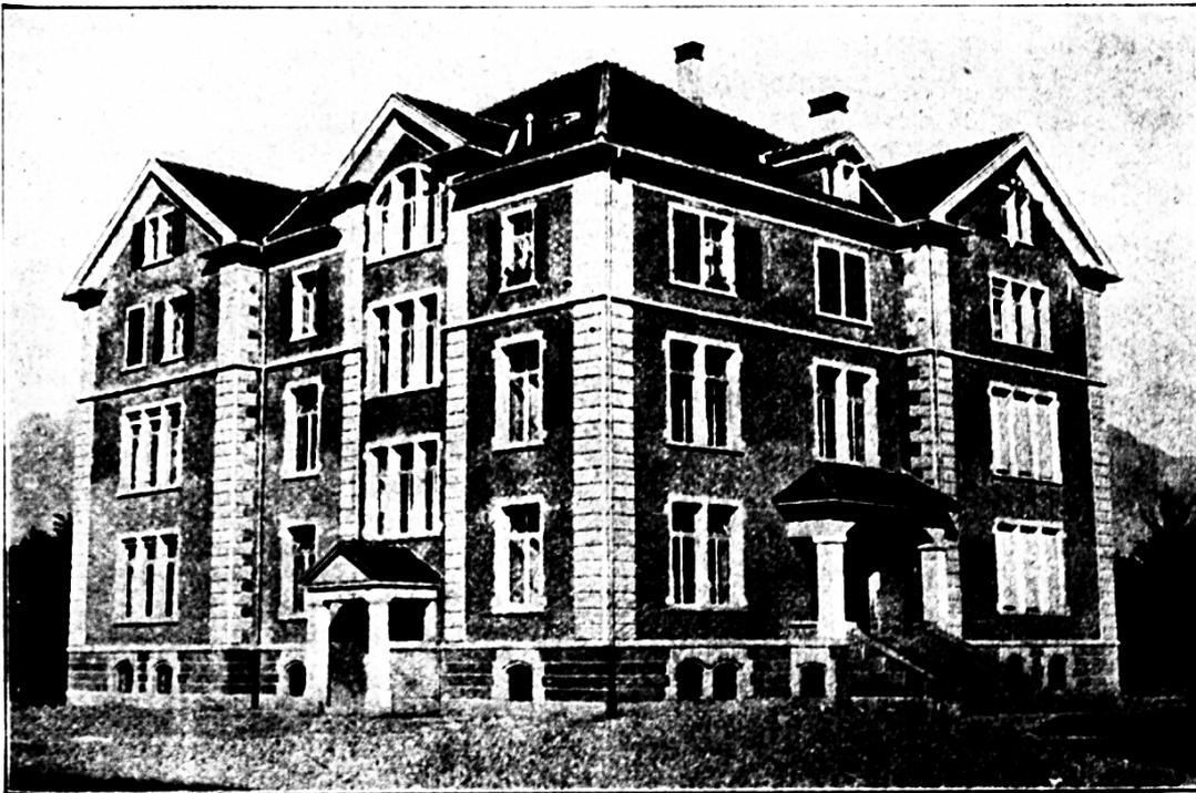
mit 4 Zimmern, Küche und Abort. Im Hause ist elektrische Beleuchtung, Wasserleitung bis zur Abwartwohnung und damit verbundene Spülung der Aborte. Die Heizung geschieht durch Dampfwasser; sie ist montiert von Firma Stehle und Gutfnecht in Basel und sind 2 Heizkörper, ein größerer und ein kleinerer zur Verfügung und ist Heizung sämtlicher Lokalitäten des Hauses möglich.
