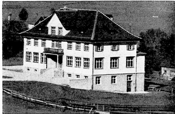
Neues Schulhaus Eggerstanden.
