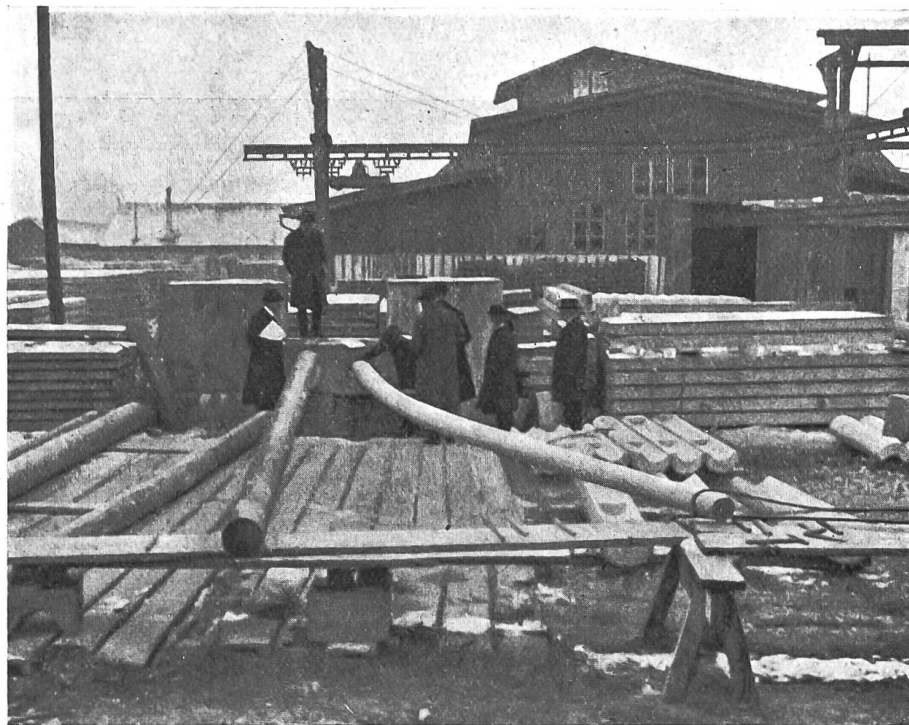
Fig. 10. Anordnung der Belastungsversuche mit „Universalsockeln“.
