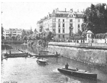
Fig. 16. Spitze des Kabelzuges im Schanzengraben.
