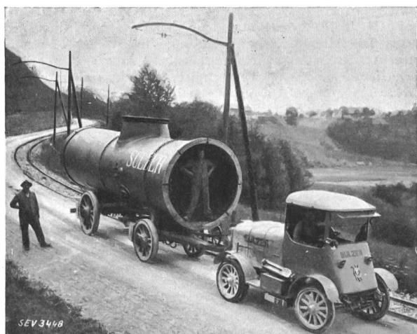
Fig. 3. Akkumulatortraktor. Zugkraft 10 t.
