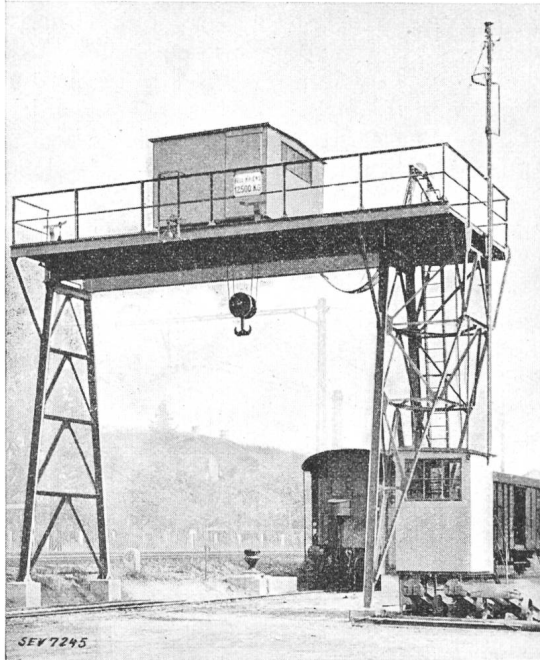
Fig. 5. Feststehender Bockkran mit Rangierspill.
