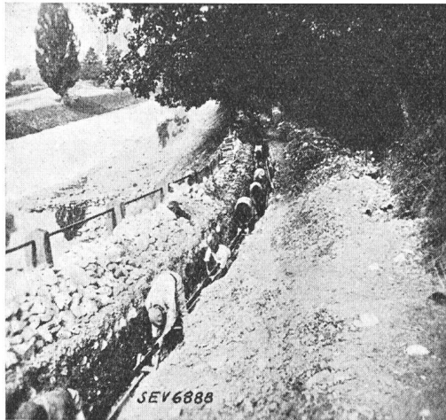
Fig. 30. Kabeltransport auf Rollen im Kabelgraben.
