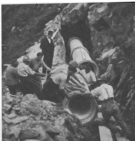
Fig. 2. Zuleitung der Reuse de Saleinaz Wasserleitung aus Superbetonschleuderröhren zur Entsandungsanlage nach System Dufour
