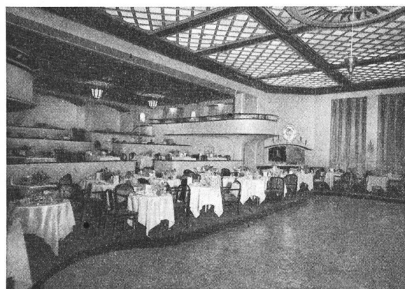
Fig. 2. «Embassy» nach dem Umbau; Blick gegen Empore
