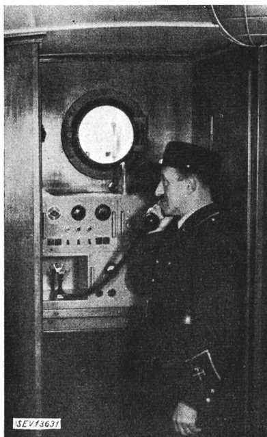
Fig. 11. FM-Funkstation in einem Löschboot der Basler Feuerwehr
