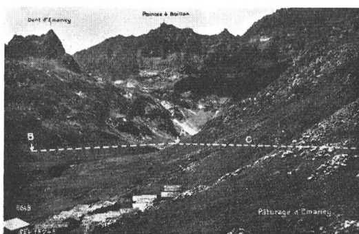
Fig. 3 Die Wasserfassung des Triège A Wasserfassung B Stolleneingang rechter Talhang C Zuleitung linker Talhang
