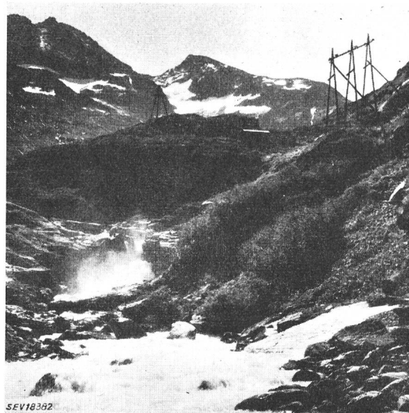
Fig. 2 Abspannstützpunkte 16-kV-Leitung Innertkirchen-Gauli
