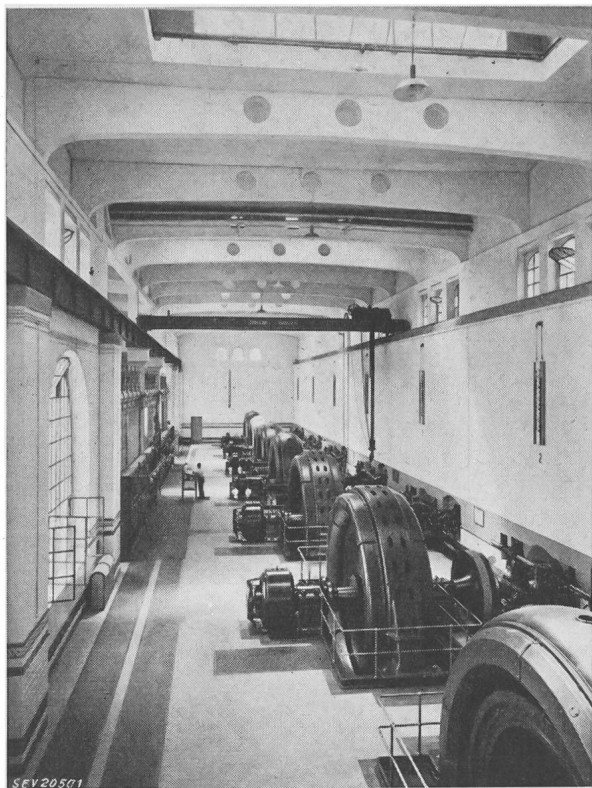
Fig. 1 Blick in den Maschinensaal
