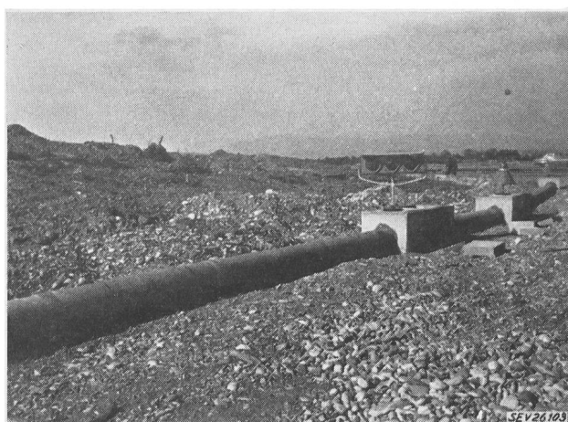
Fig. 3 Zementrohrleitung mit Lampenkasten Rechts eine Pistensperroleuchte mit einer grünen und zwei roten Lampen
