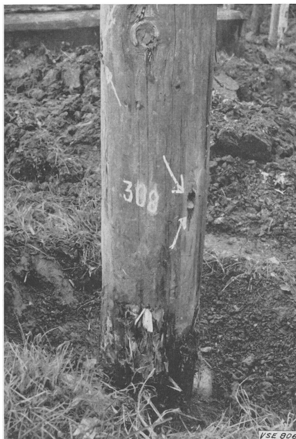
Fig. 5 Mit einem öligen Schutzmittel mittels Bohrlochtränkung nachgepflegte Stange, von Pilzen angegriffen
