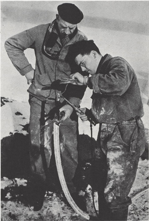
Fig. 25 Kabelmontage
