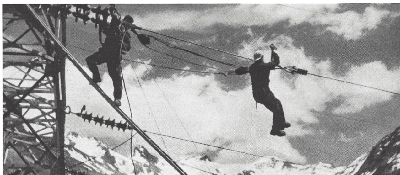
Fig. 19 Reparaturarbeiten an der Gotthard-Leitung
