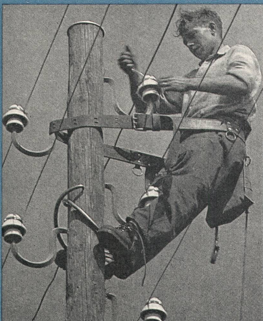
❸ Arbeit an einer 16 kV-Leitung
