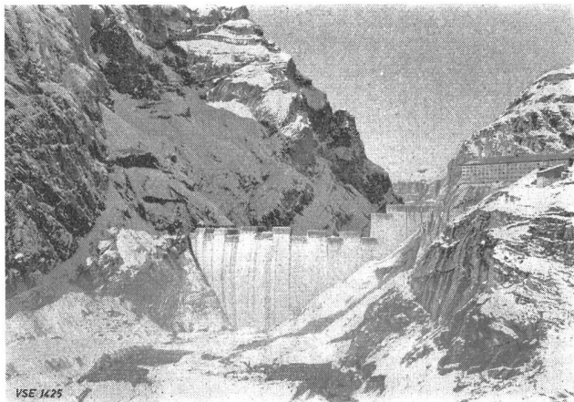
Fig. 4 Kraftwerke Linth-Limmern Staumauer Limmernboden
