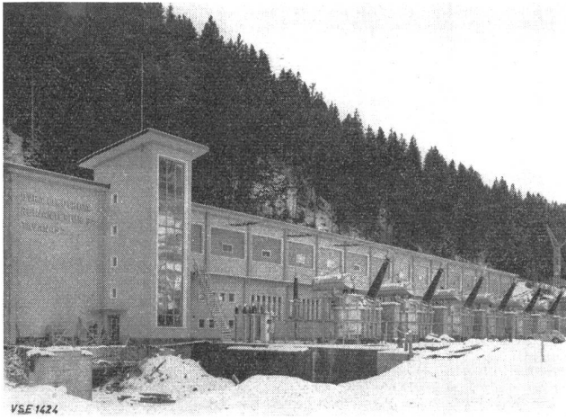
Fig. 3 Kraftwerke Vorderrhein Zentrale Tavanasa
