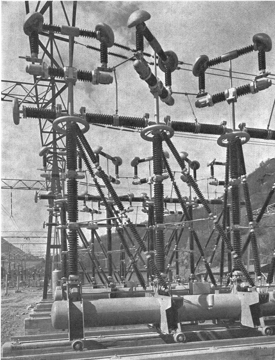
◀ In der Zentrale **Tavanasa** der Kraftwerke Vorderrhein AG, Disentis, Schweiz, befinden sich zwei dreipolige 380 - kV - Druckluftschneilschalter-Gruppen mit einer Ausschaltleistung von je 12 000 MVA zum Schalten der schweizerischen Höchstspannungs - Überlandleitungen.
