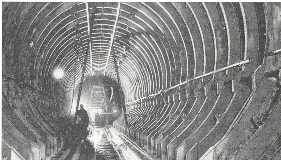
Fig. 21 Druckstollen Sufers—Bärenburg der Kraftwerke Hinterrhein
