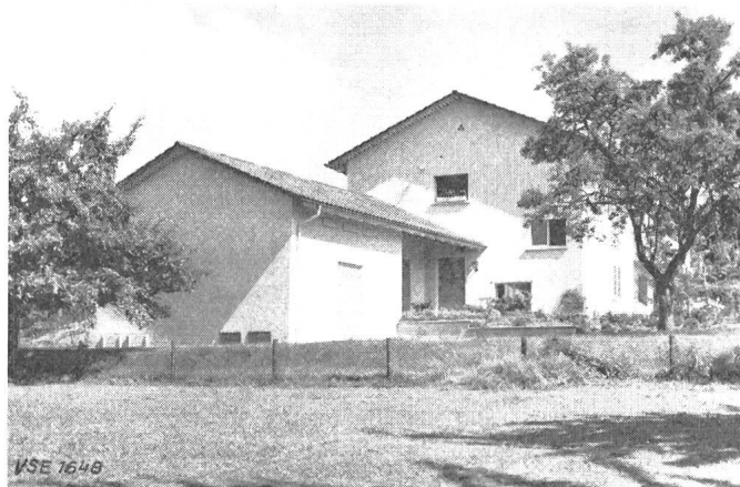
Fig. 1 Transformatorstation, unter Zwischenschaltung einer Garage an ein Einfamilienhaus angebaut
