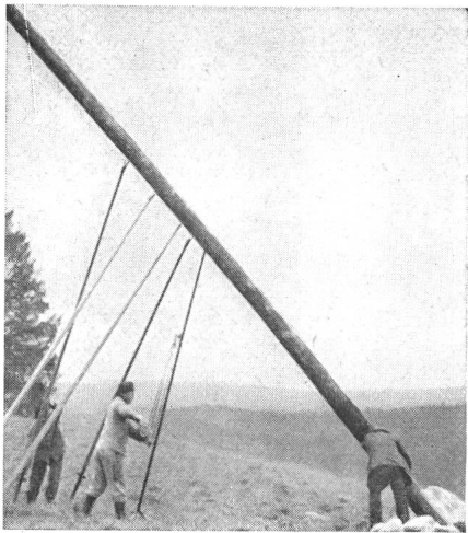
Leitungsbau im Kanton Bern mit LIFTY Stangenwinde
