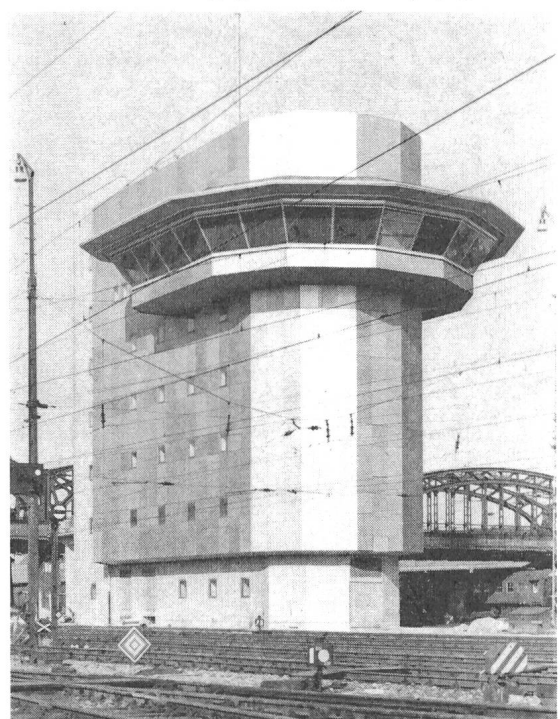
Fig. 1 Das neue Zentralstellwerk
