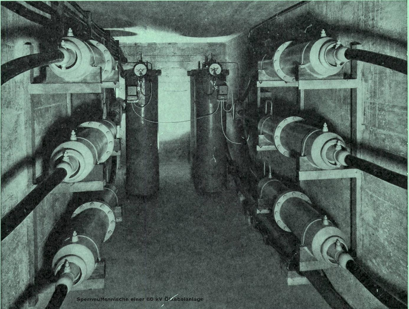
Sperrmuffennische einer 60 kV Öl-Kabelanlage
