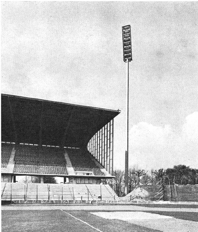
Fig. 1 Flutlichtanlage des Stadions in Duisburg-Wedau
