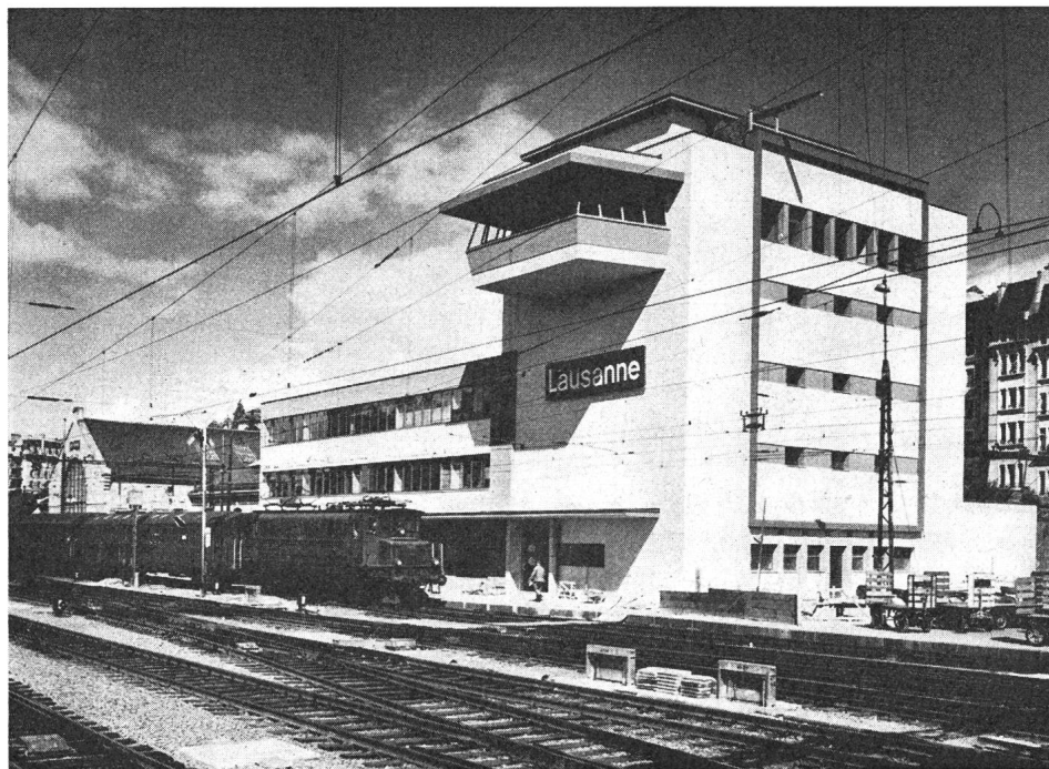
Fig. 2 Poste directeur de la gare de Lausanne
