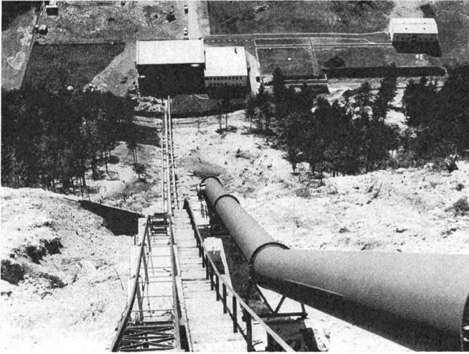
Fig. 7 Das Diessbachwerk mit vorerst einer Druckrohrleitung
