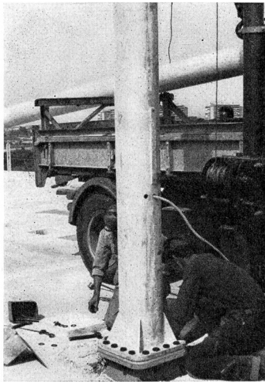
Fig. 4 Fixation d'un mât sur le viaduc
